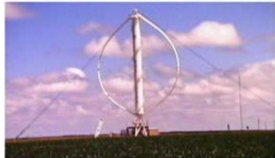
4. ábra. Darrieus-szélkerék
